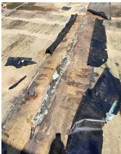
LOKO – Průběžné opravy střech z důvodu zatékání
