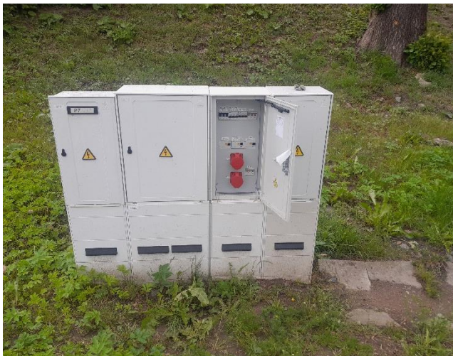
LBO – Opravy a úpravy elektroinstalací pro potřeby Českého atletického svazu
